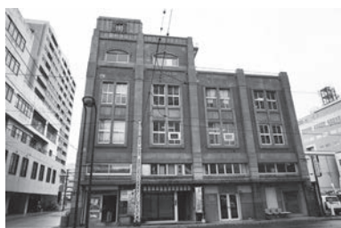
熊本県組合が入居している「早野ビル」、1924年に建造された熊本で最初の貸ビルで登録有形文化財。熊本地震でも倒壊しなかった。
