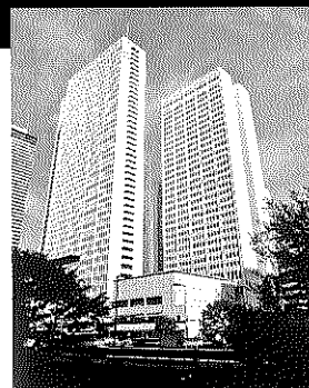
京王プラザホテル全景
